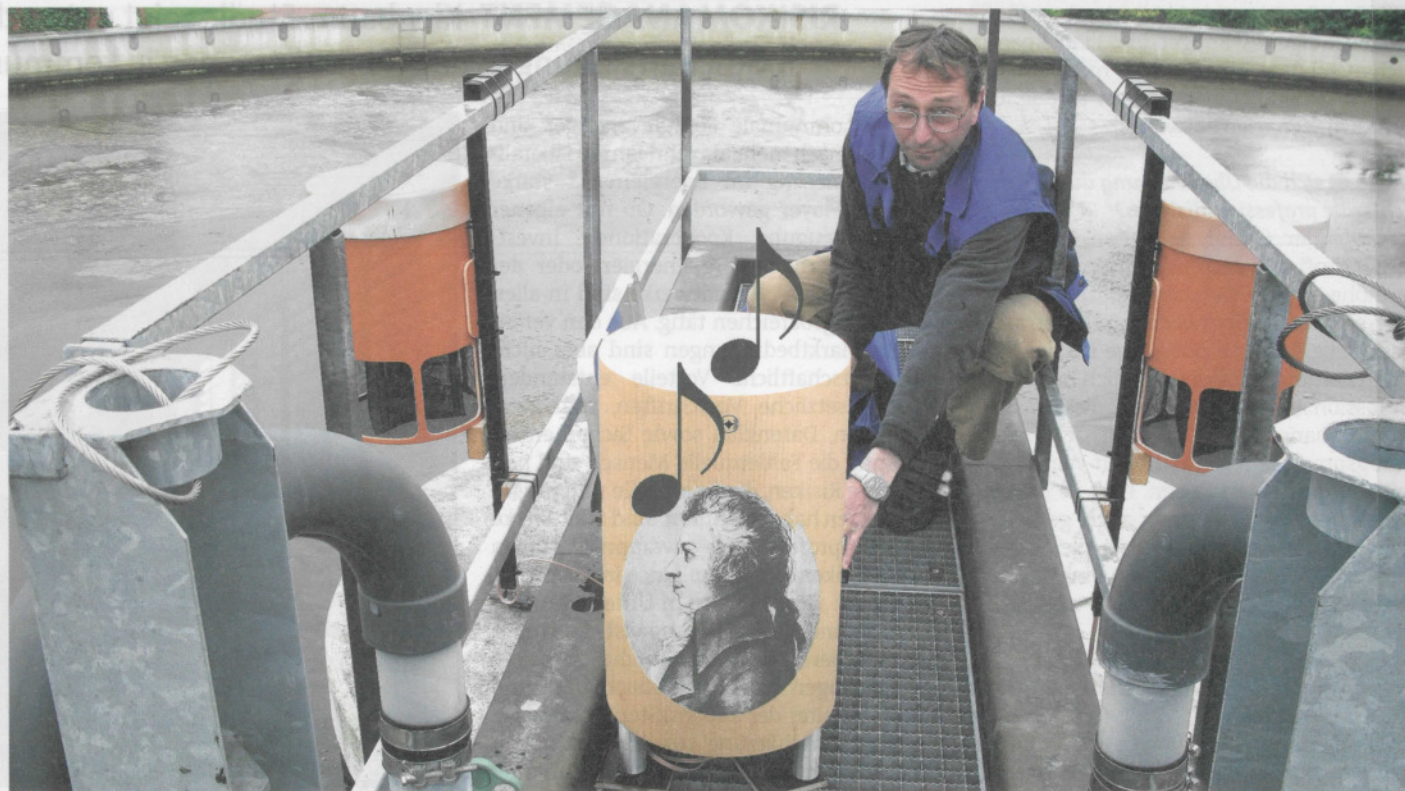
Klärwerksmeister Detlef Dalichow rückt das Tieftonmodul auf der Brücke über dem Belebungsbecken in Position. Links und rechts neben ihm hängen am Geländer die orangen eigentlichen Kugelschallelemente. Auf die Box in der Mitte wurde in dieser Fotomontage ein Porträt von Wolfgang Amadeus Mozart sowie Noten retuschiert, um die Musik zu symbolisieren, die Mensch und Mikrobe wohl tut. Bild: R. Meinusch
